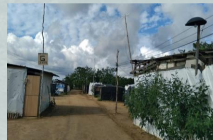
Rede de Energia
