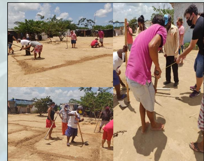
Exercício de demarcação das paredes da Proposta Preliminar.
